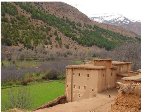
Maison des Aït Boughez
